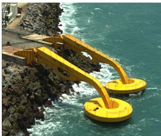
**FIGURA 5: PROTÓTIPO DO CONVERSOR HIPERBÁRICO INSTALADO NO PORTO DO PECÉM (2010-2014).**
