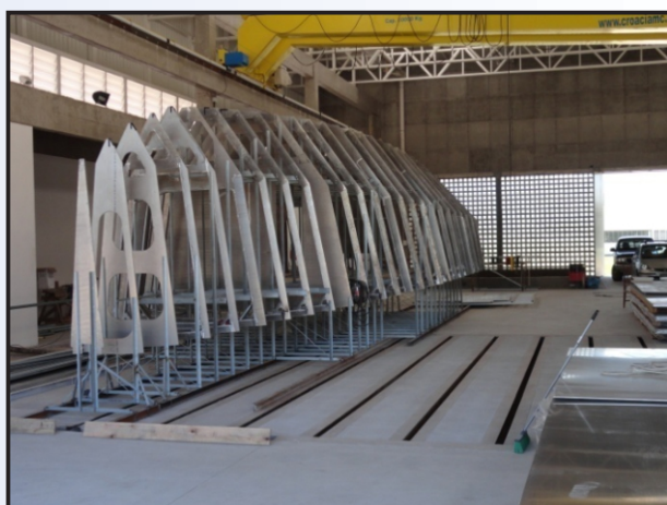
Figura 2 - Veleiro ECO - UFSC60 em seu estágio de conclusão de caverna nas instalações do INPETRO/Sapiens Parque
