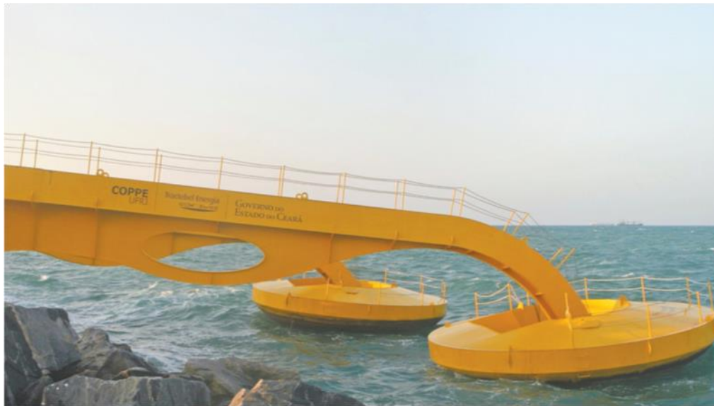
Figura 6 – Planta piloto de conversão da energia de ondas em eletricidade, em instalação no quebra-mar do porto de Pecém
